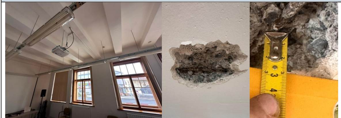
Fotografie – Budova A – sonda monolitický strop
