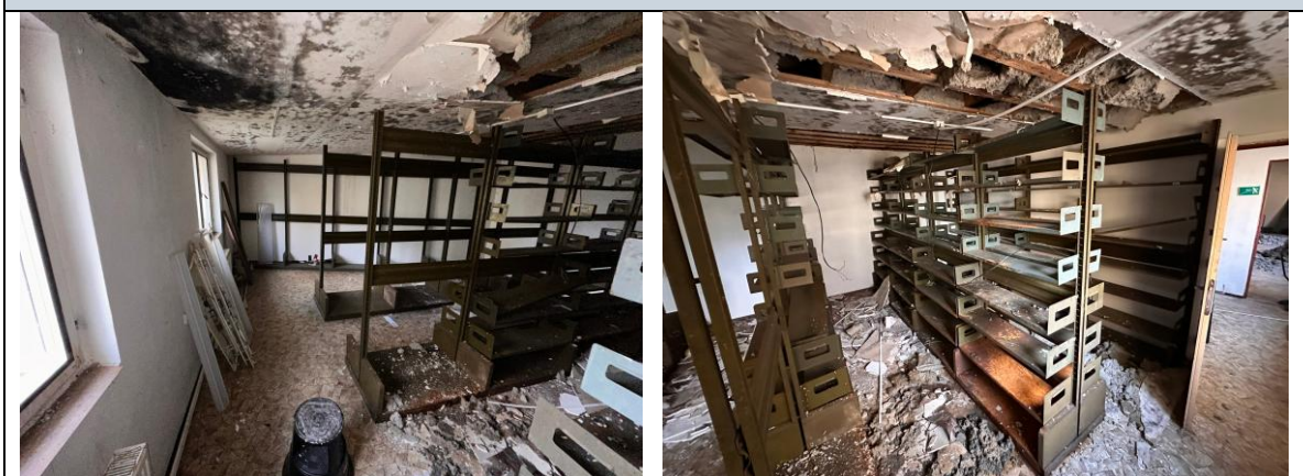
Fotografie Budova D – biologické napadení stropní konstrukce – havarijní stav
