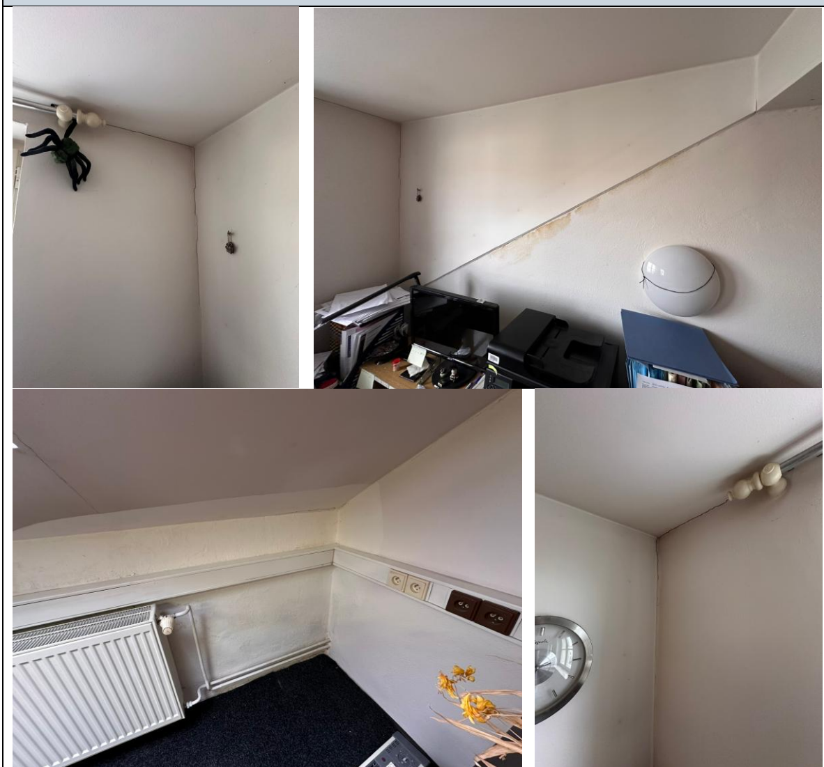
Fotografie Budova C – trhliny kolem uličního štítu a SDK záklopu vestavby
