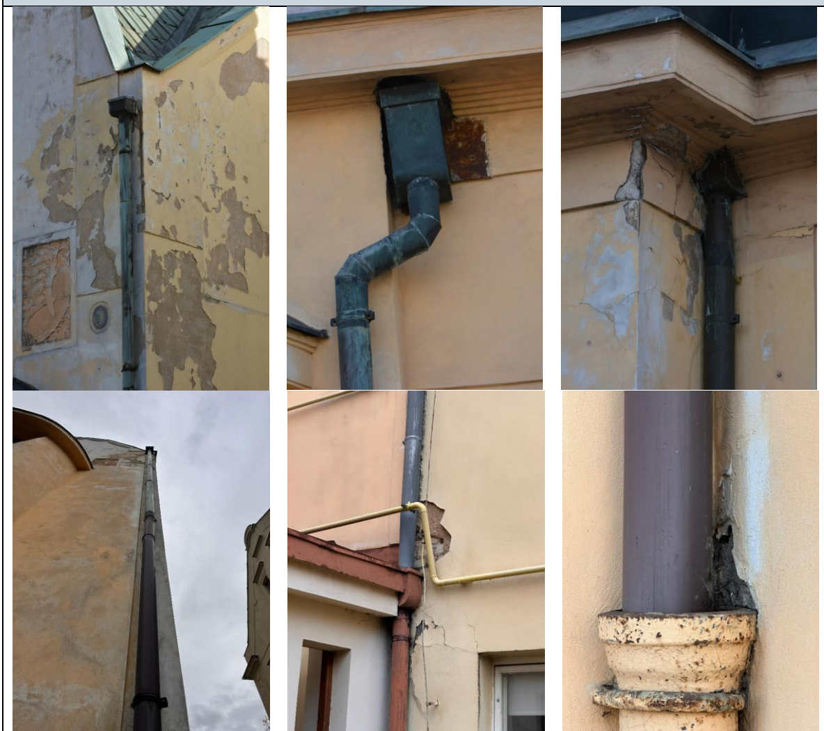
Fotografie Budova A – dešťové svody, ilustrativně, prakticky všechny vyhodnoceny jako havarijní
