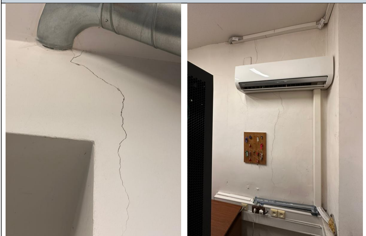
Fotografie Budova C – vestavba, trhliny v nadpraží, trhliny server
