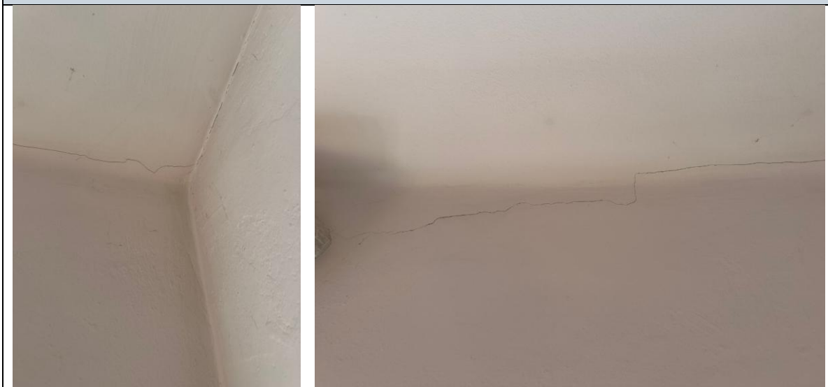
Fotografie – Budova B – trhliny stropů, staticky nevýznamné
