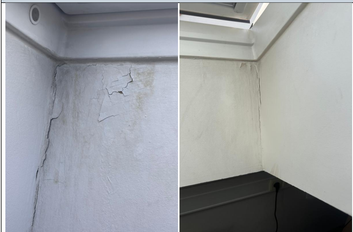
Fotografie Budova C – zatékání do podkroví
